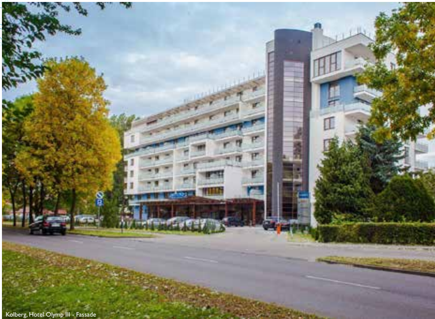
Kolberg, Hotel Olymp III - Fassade
